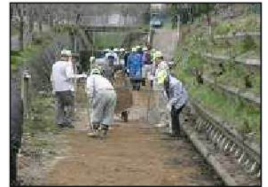
土を入れて遊歩道の整備をしています
