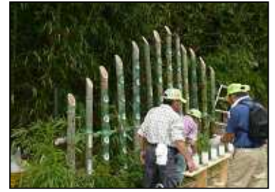
大灯籠を現地に据え付けています
