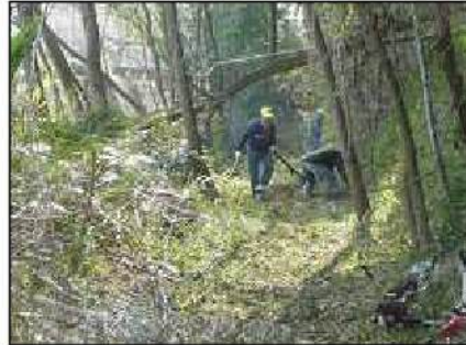
作業にかかる前の状況です
